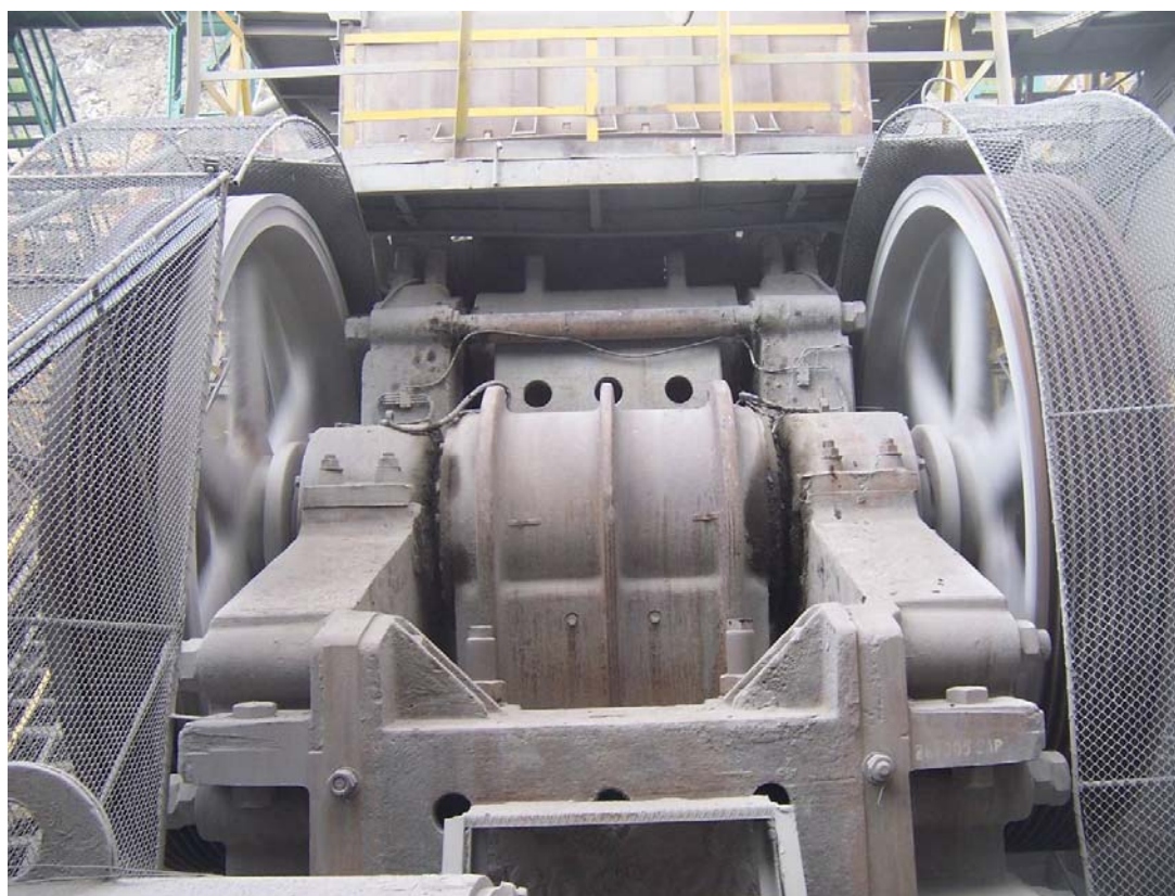
Jednospěrný drtič V10 – problematický přístup.
