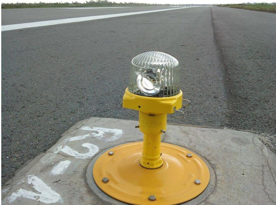
Obrázek 5.7 Nadzemní návěstidlo (Zdroj: flyingchinaman)
