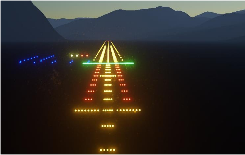
Obrázek 5.6 Přibližovací světelná soustava a dráhová světla (Zdroj: oculus.com)
