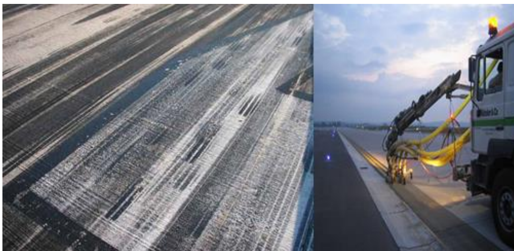
Obrázek 9.2 Odstraňování pogumování RWY tlakovou vodou (Zdroj: airport-technology.com)
