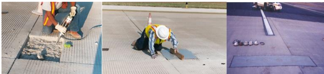
Obrázek 9.1 Oprava cementobetonové plochy (Zdroj: transpo.com)
