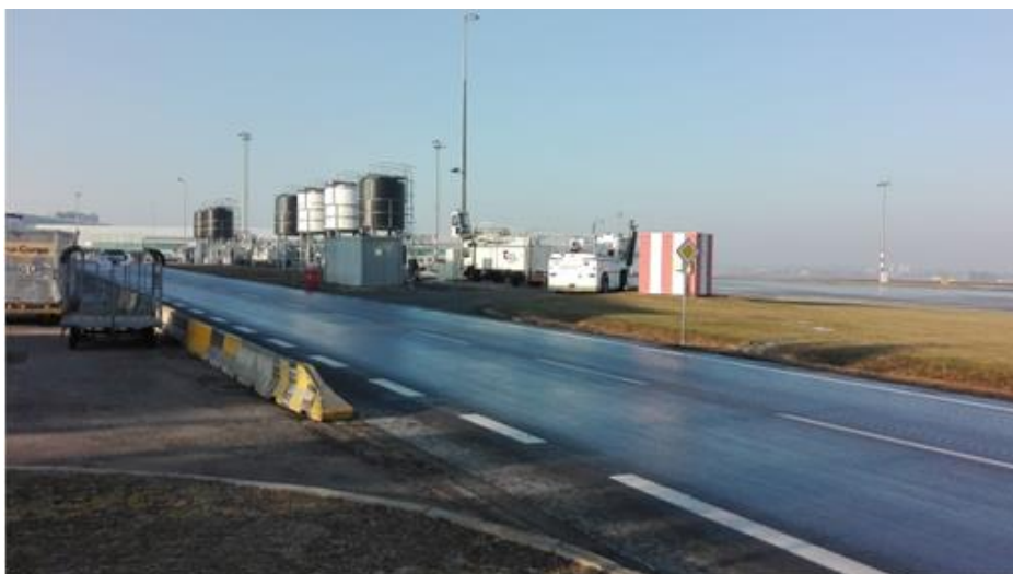
Obrázek 12.1 Zásobníky odmrazovací kapaliny na letišti Praha (Zdroj: autor)
