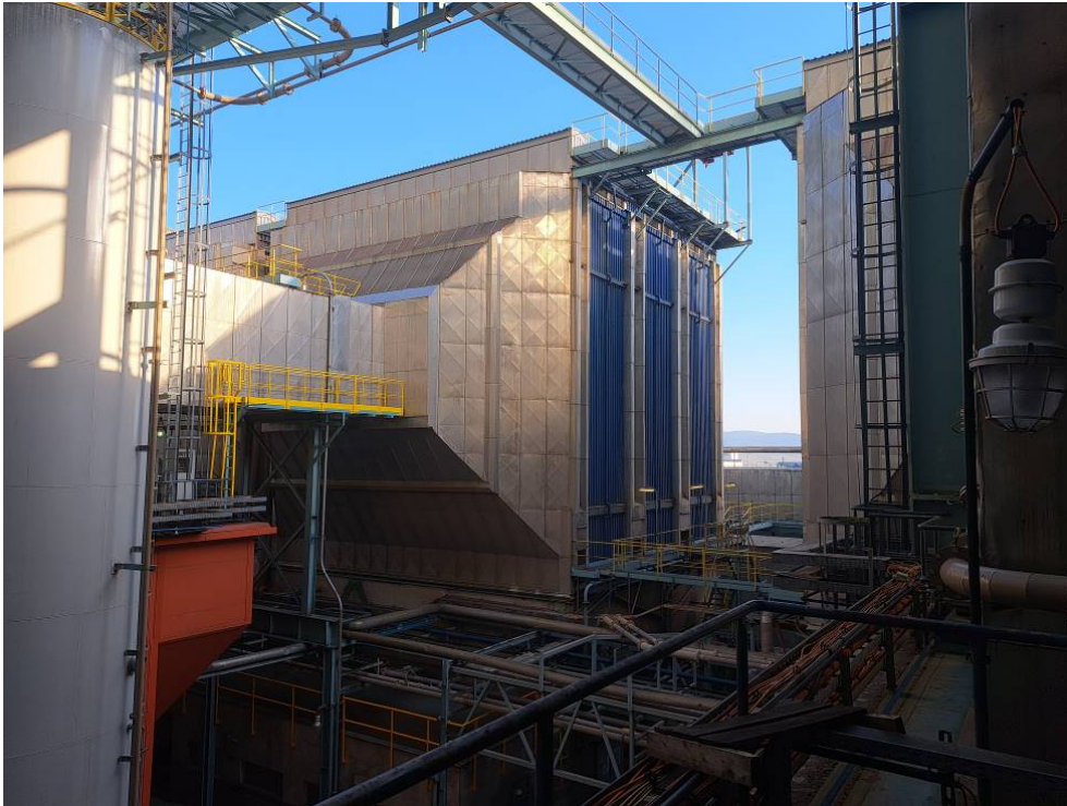
Obr.1 Objekt látkových filtrů bloku B
