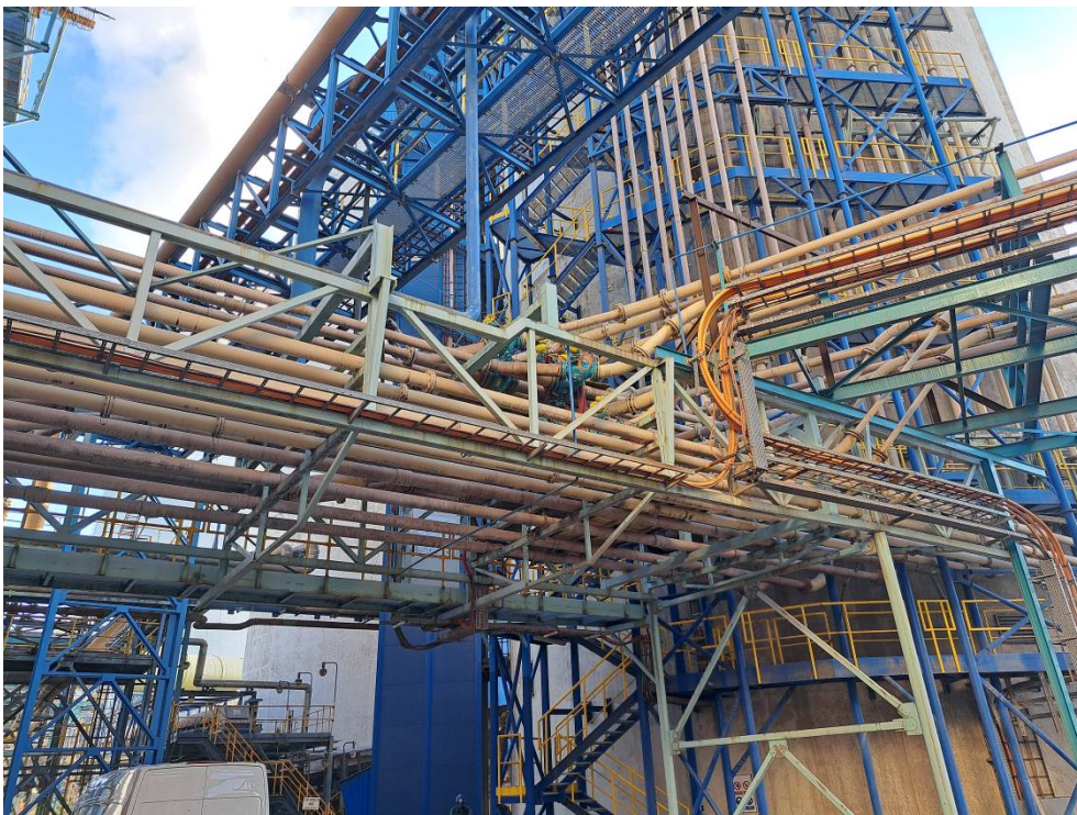
Obr.3 Odbočka pseudopravy popílku před betonovými sily do Distribučního centra
