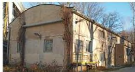
Budova kompresorové stanice
