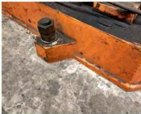
Dotahovaný kotvící šroub
